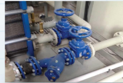
蘇閩金屬電鍍生產線
